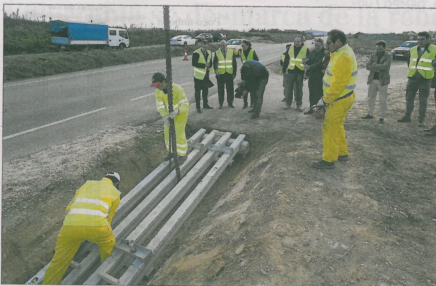
Trabajos de instalación de un dispositivo de seguridad en un salvacunetas, ayer en el término municipal de Cigales. / PHOTOGENIC
