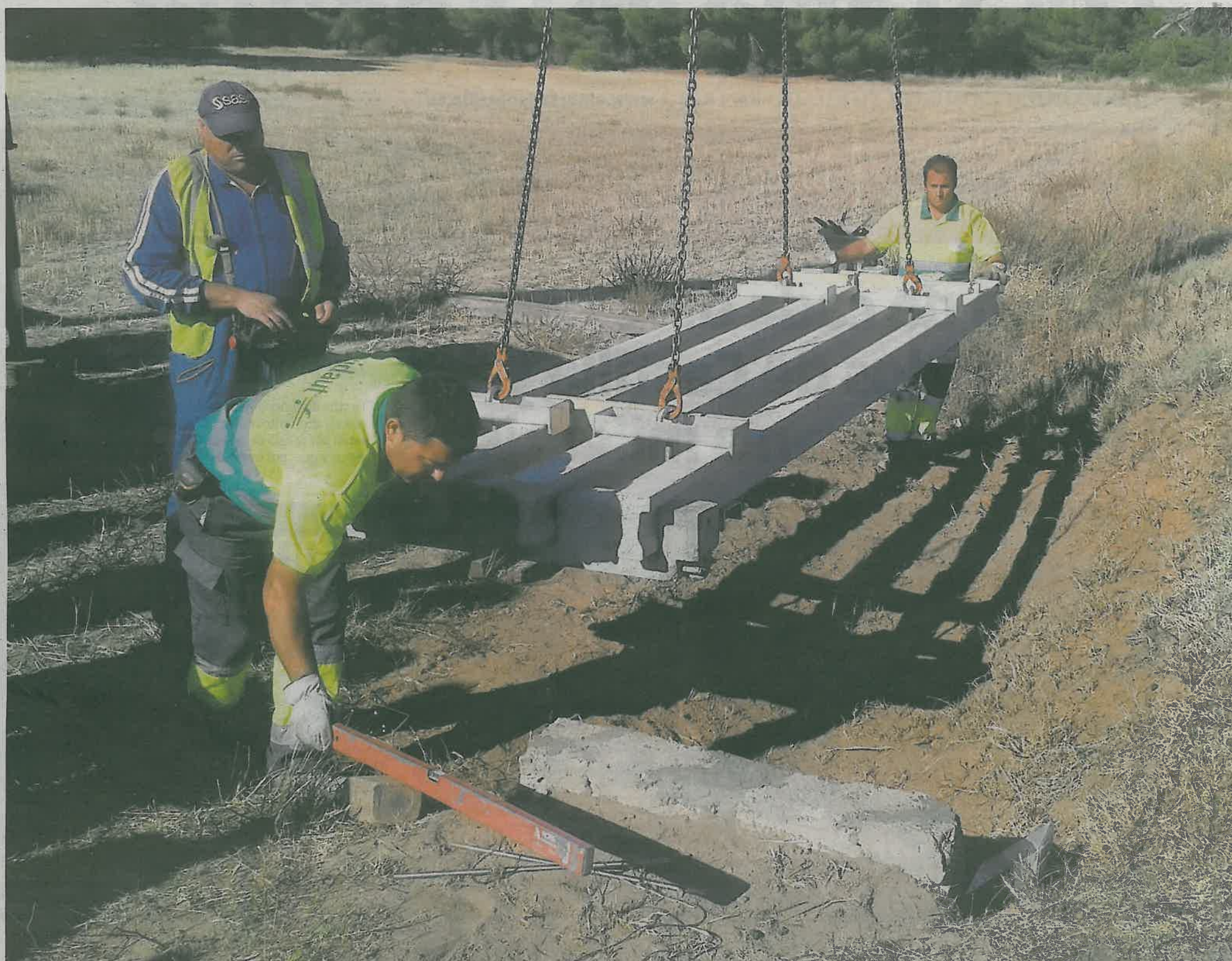
Proyecto piloto instalado en uno de los pasos salvacunetas en el kilómetro 9 de la VP-9904 (carretera Medina del Campo-Olmedo, por La Zarza). :: EL NORTE
