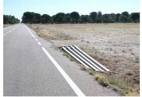
✓ Los componentes están fabricados en materiales que garantizan una durabilidad del conjunto superior a los 25 años en cualquier tipo de ambiente, al constituirse por elementos prefabricados de hormigón armado y la utilización de elementos de unión y soporte en acero galvanizado.
