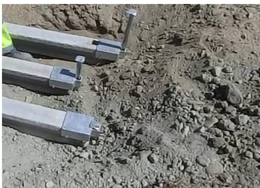
*Imagen 9.- Fijación de los extremos inferiores de los elementos longitudinales*
