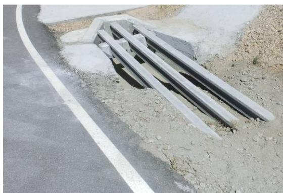
*Imagen 2.- Instalación de protector sobre paso salvacunetas de hormigón*
