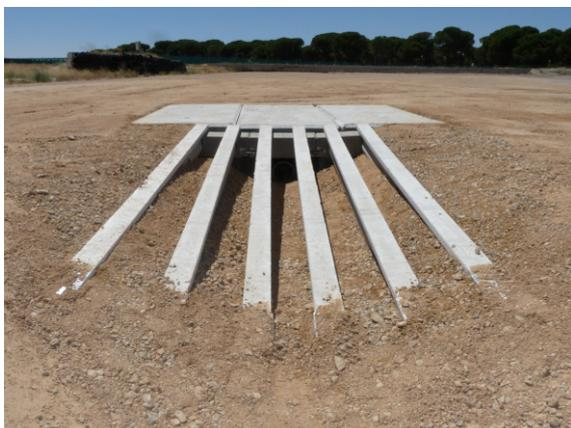
Imagen 11.- Configuración de cuneta de 2,7 metros de anchura (protector formado por tres módulos)
