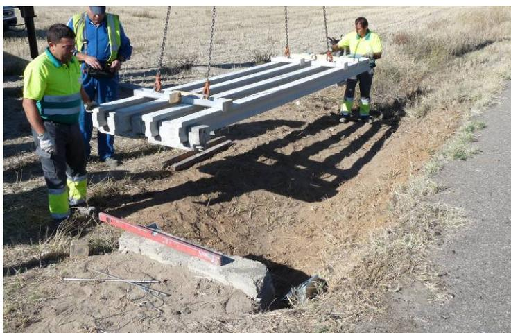
*Imagen 21.- Manipulación de sistema de protección formado por dos módulos*
