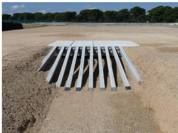
Imagen 12.- Configuración de cuneta de 4 metros de anchura (protector formado por cinco módulos)
